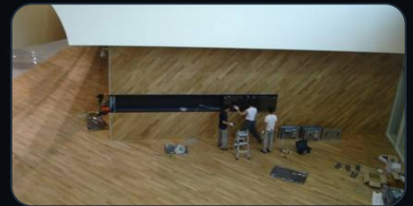
킨텍스 전시장 멀티비전 설치
