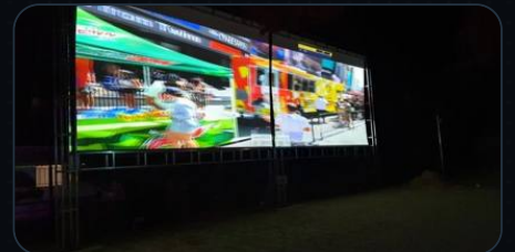
옥외용 고휘도 빔프로젝터 공사
