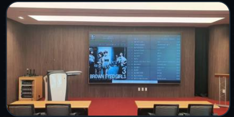
(주)시스원 멀티비전 설치
