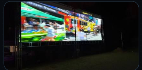
옥외용 고휘도 빔프로젝터 공사
