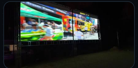
옥외용 고휘도 빔프로젝터 공사
